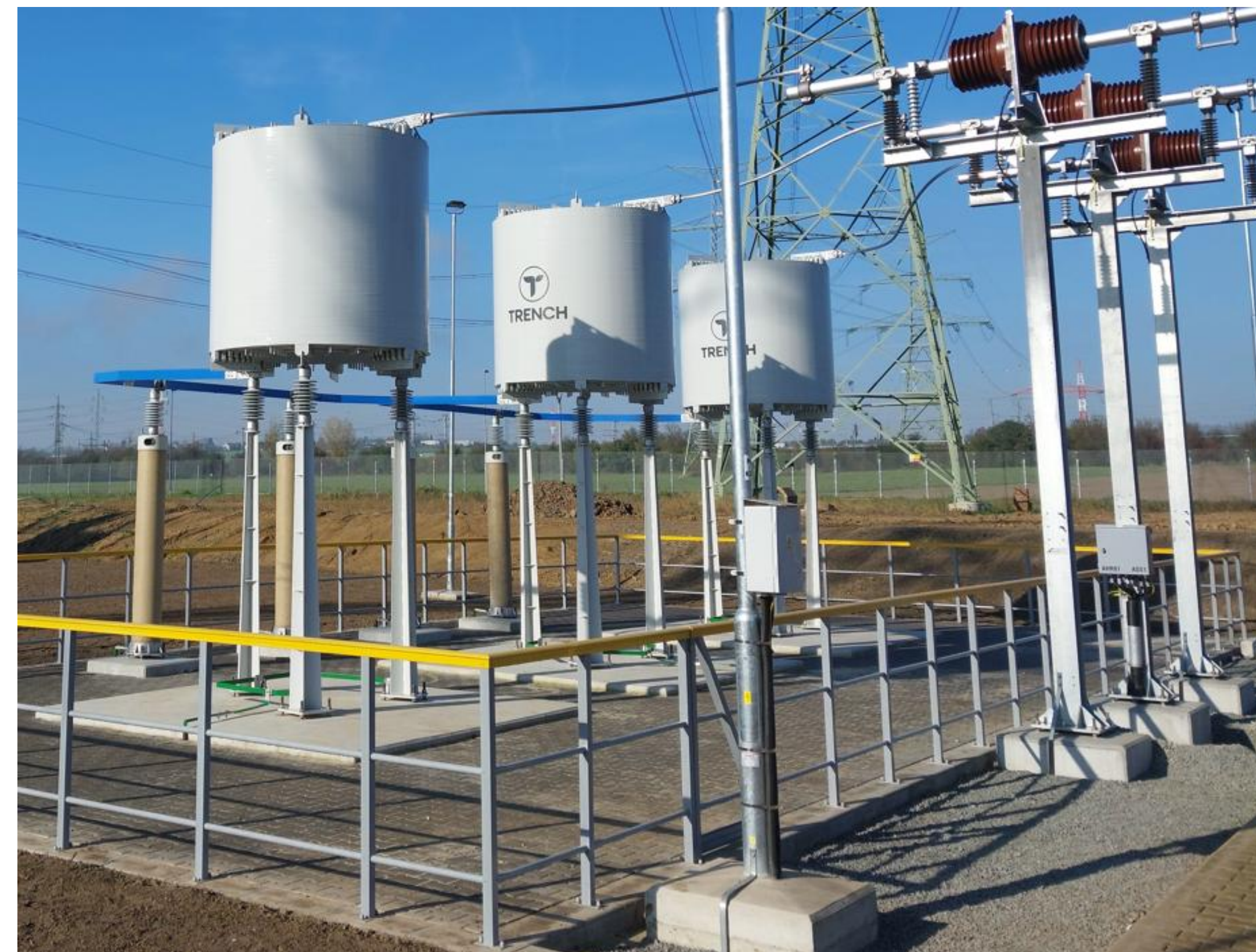
Terciárová tlumivka 3x15 MVar resp. 3x20 MVar (10,5 kV; 33 kV)
